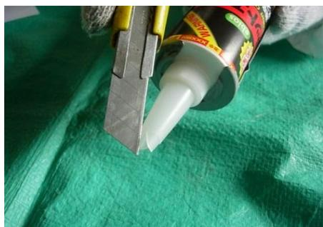
カートリッジ先端のノズルをケーブルや配管の太さに応じてV字にカットして下さい。
