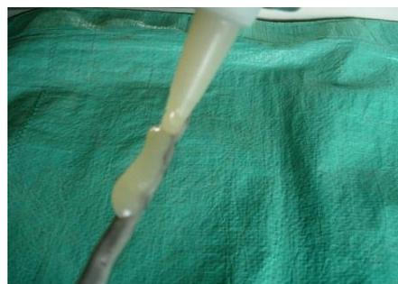
V字にカットしたノズルの先端をケーブルや配管に当てジェルを塗布して下さい。
